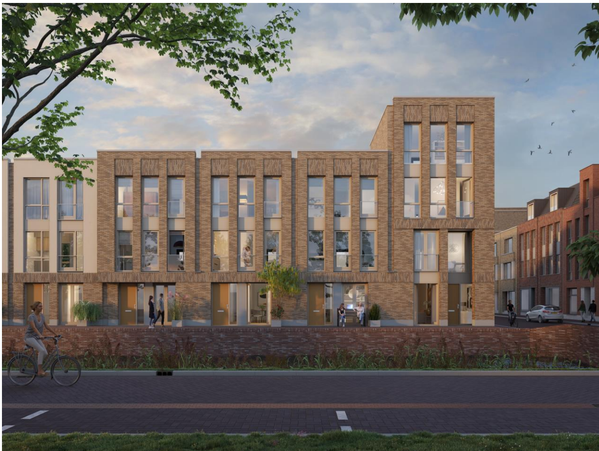
22 woningen Schoorlaan te Leidschendam
